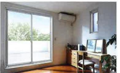
アルミサッシは、ガラスがめ込まれている障子と、窓を支える枠からなります。1組20~50kgほどの重量があり、繊細な組立技術が必要とされます。
